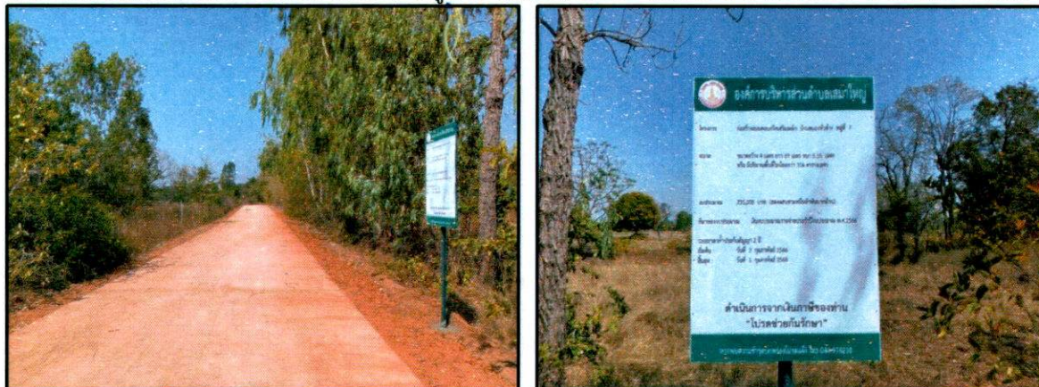
โครงการปรับปรุงถนนผิวจราจรแอสฟัลต์ติกคอนกรีต บ้านโนนใหญ่ หมู่ที่ ๘ จากบ้านนายอริย์ การถาง -บ้านนายสำเริง เพชรภูวงษ์
