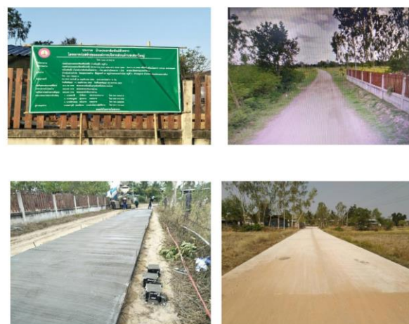
โครงการก่อสร้างถนน ค.ส.ล.บ้านโนนตัว หมู่ที่ ๖ บริเวณจากบ้านนายอดุลย์ กุพันธ์ ถึง โรงเรียนบ้านหนองแจ้งน้อย (ข้อบัญญัติ)
