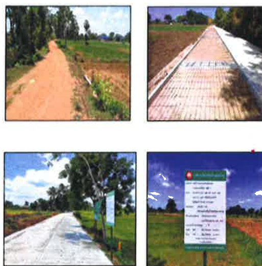
โครงการก่อสร้างถนน ค.ส.ล. บ้านหนองแจ้งน้อย หมู่ที่ ๕ บริเวณ บ้านร้อยศรีเจ็ด ไปสวนนายประจวบ ช่างเหล็ก (ข้อบัญญัติ)
