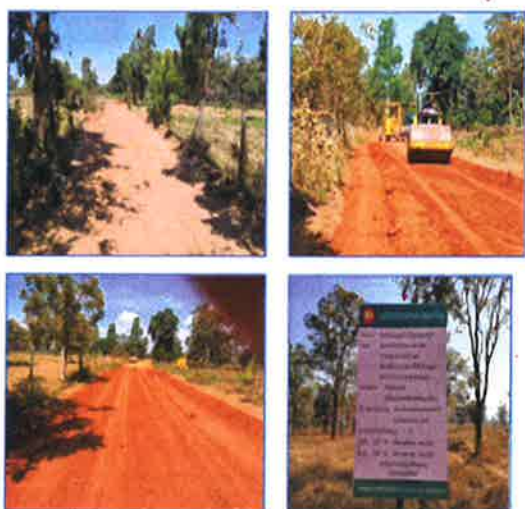
โครงการก่อสร้างถนนลูกรัง บ้านดอกบก หมู่ที่ ๕ บริเวณจากแยก ไปบ้านโนนนางาม ไป โศกโสภนหาย (ข้อบัญญัติ)
